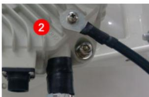
3. Certifique-se de que os outros conectores dos cabos de aterramento estejam bem fixados junto à braçadeira do mastro e use fita tire-up (fita Hellerman) para organizar a distribuição dos cabos, conforme imagem ilustrativa abaixo.
