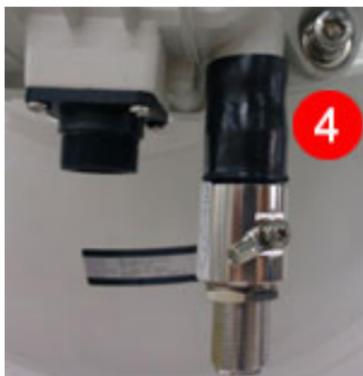
5. Use novamente no conector a fita de autofusão, assegurando a vedação contra água.
