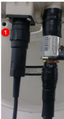
2. Após a conexão use fita de autofusão para selar os conectores, assegurando a vedação contra água.
