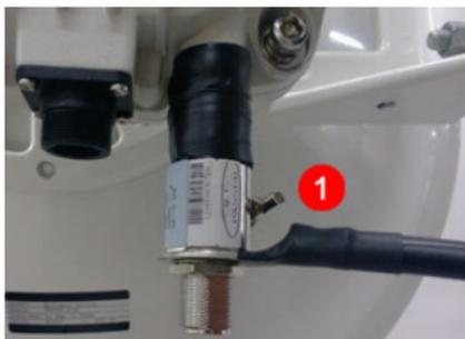
2. Aperte o conector N do cabo de alimentação e sele com fita de autofusão, assegurando a vedação contra água.
